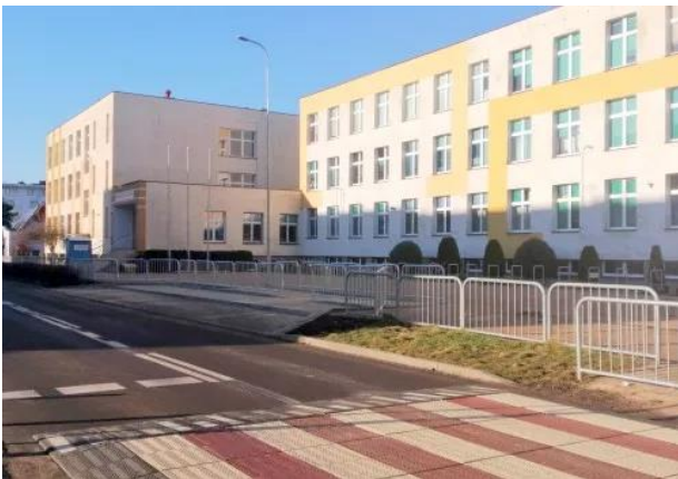
BUDOWA ZATOKI POSTOJOWEJ PRZY SZKOLE PODSTAWOWEJ NR 18
